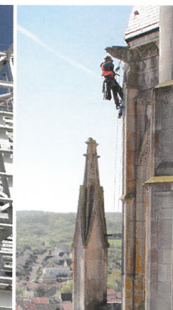
> Kunstgeschichte aus der Nähe: Inspektion der Wasserspeier, Wallfahrtskirche Saint-Nicolas-de-Port
