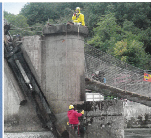
> Arbeiten an einer Brücke über dem Doubs
