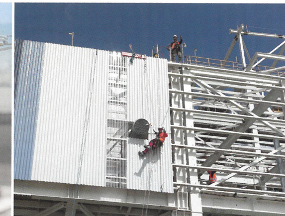
> Anbringung der Fassadenverkleidung (Energiezentrale/Marokko)
