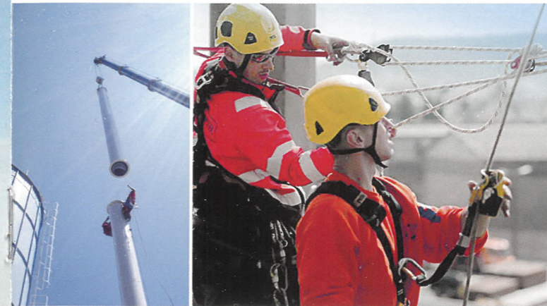
> Montage eines Kamins, Höhenarbeiter und Kran im Einsatz
